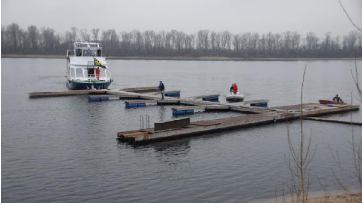
12. Dezember 2013: Der erste Teil der Steganlage kommt am neuen Ufer an.
