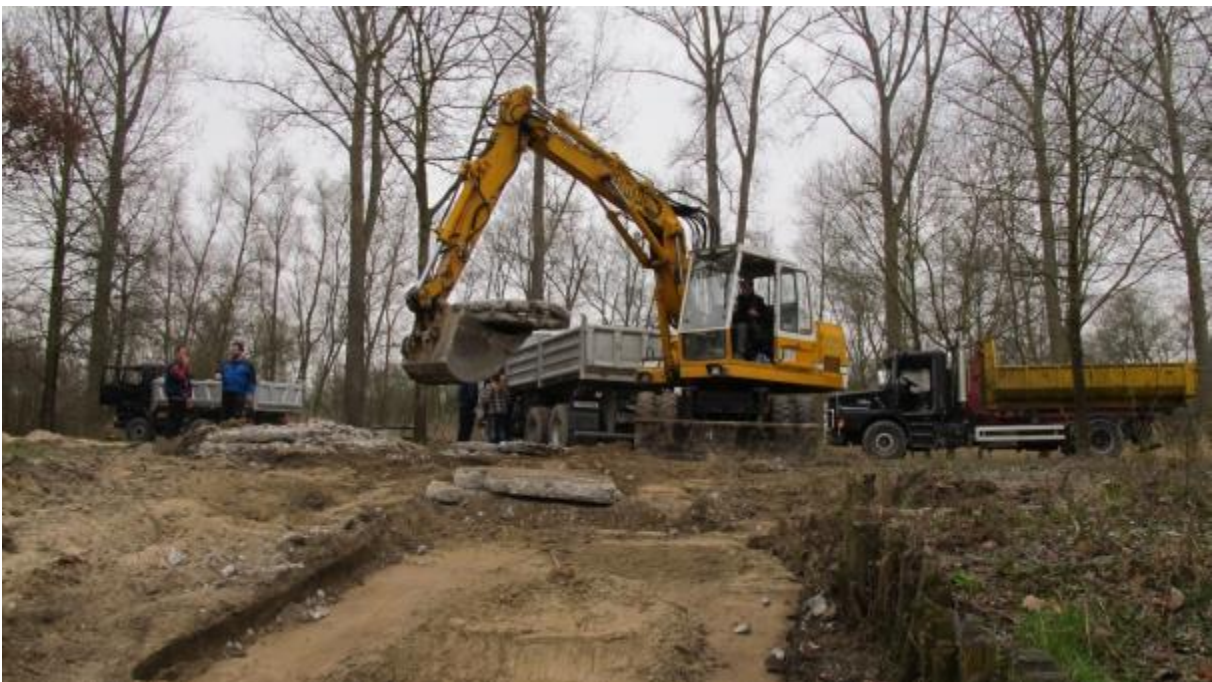
15. März 2014: Abbruch der Slipbahn auf dem alten Gelände
