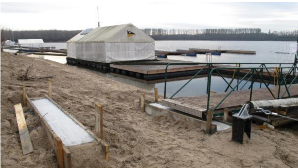
15. Dezember 2013: Auflagebalken werden betoniert
