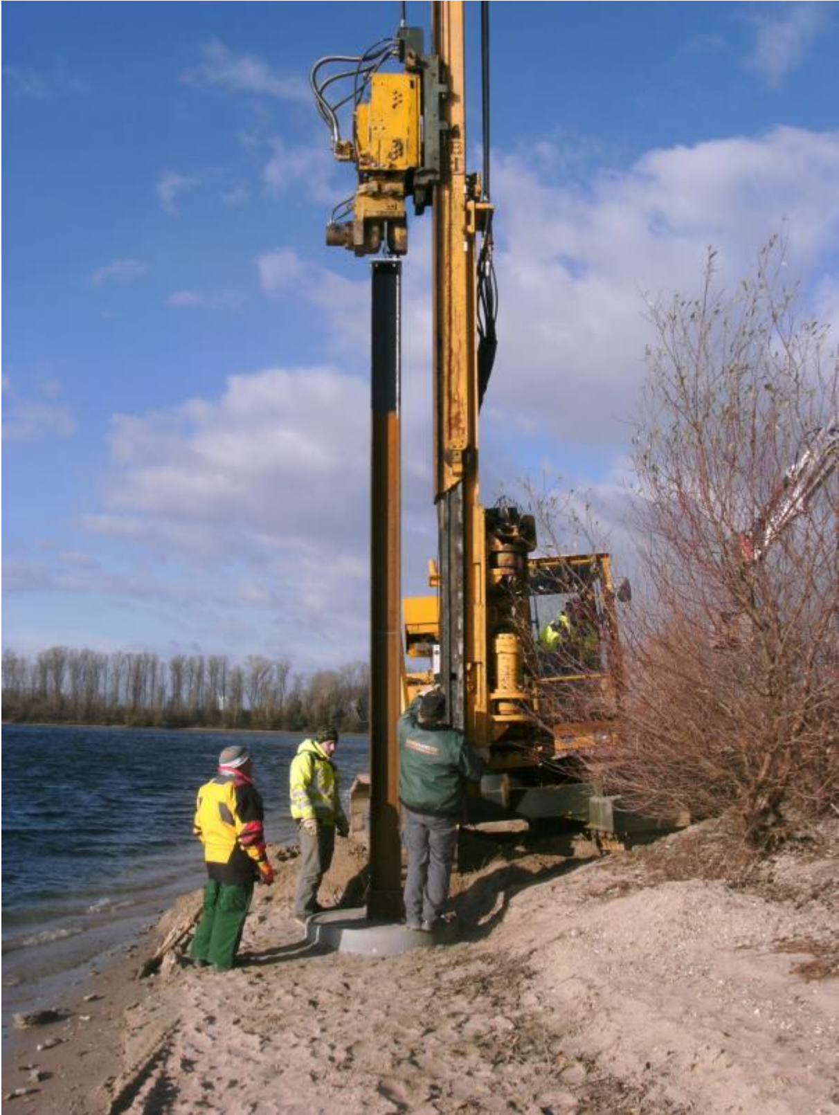
6. Dezember 2013. Die Landanker werden gesetzt
